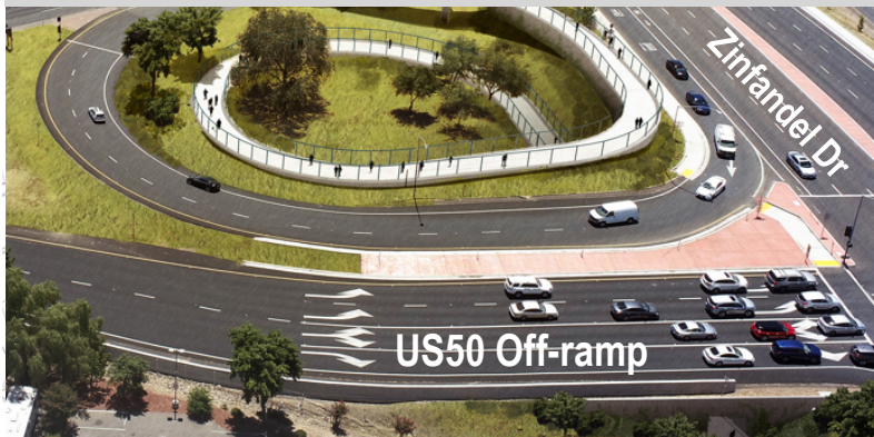
Site #3: Loop Ramp
