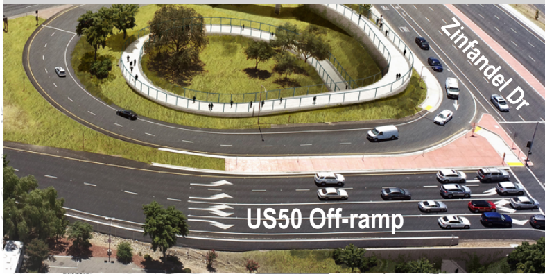
Site #3: Loop Ramp
